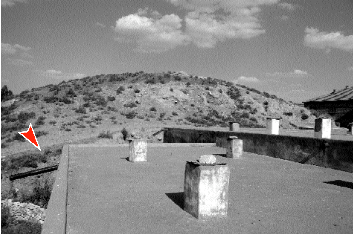
Paşalı (Nevşehir/Avanos): Bir Kalkolitik Çağ yerleşmesi olan höyük, Paşalı Köyü evleri içinde sıkışıp kalmış. Etekleri kesilerek evler inşa edilmiş. Bunlardan bazıları hala inşaat halinde. Yapılaşmanın yarattığı yoğun tahribat açıkça görülüyor.
