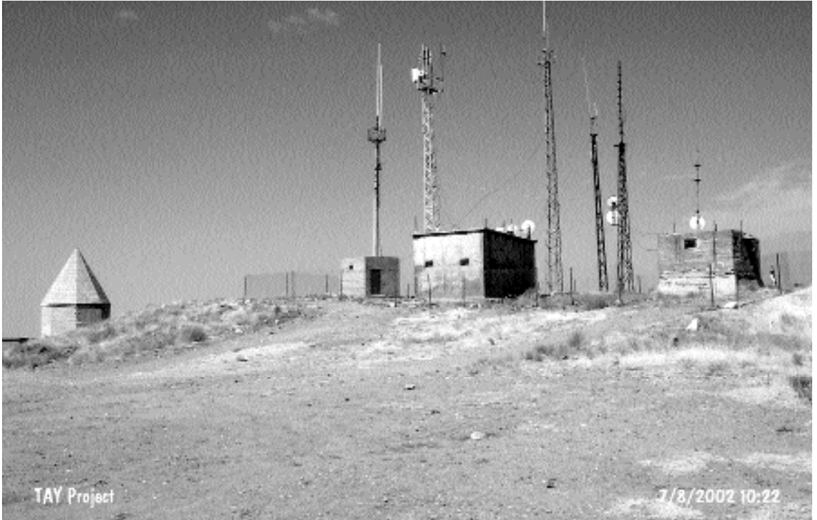
Türbe II (Aksaray/Merkez): Ervah Mezarlığı'nın en yüksek noktasında yer alan İlk Tunç Çağı höyüğünün üzerinde TV verici direkleri, baz istasyonları ve II. Kılıçarslan Türbesi yer alıyor. Höyükteki yoğun tahribatın yanı sıra, türbede de define amaçlı kazılar yapılıyor.
